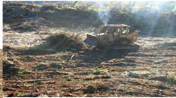
Fajeo Amontonado Buldozer
