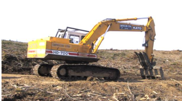
Fajeo Amontonado Excavadora
